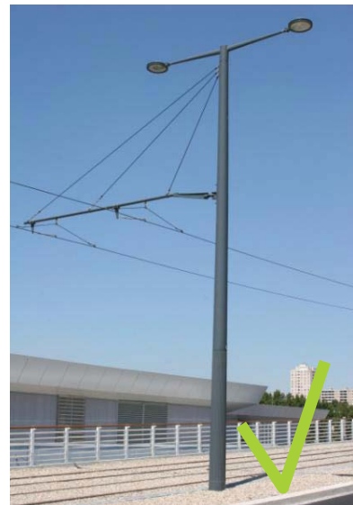
Links een mast met een externe afspanningsconstructie en lompe uithouders. In het midden een conische integraal ontworpen bovenleidingsmast. Recht een bovenleidingsmast waarbij verlichting en bevestigingsmiddelen subtiel zijn geïntegreerd in het ontwerp.
