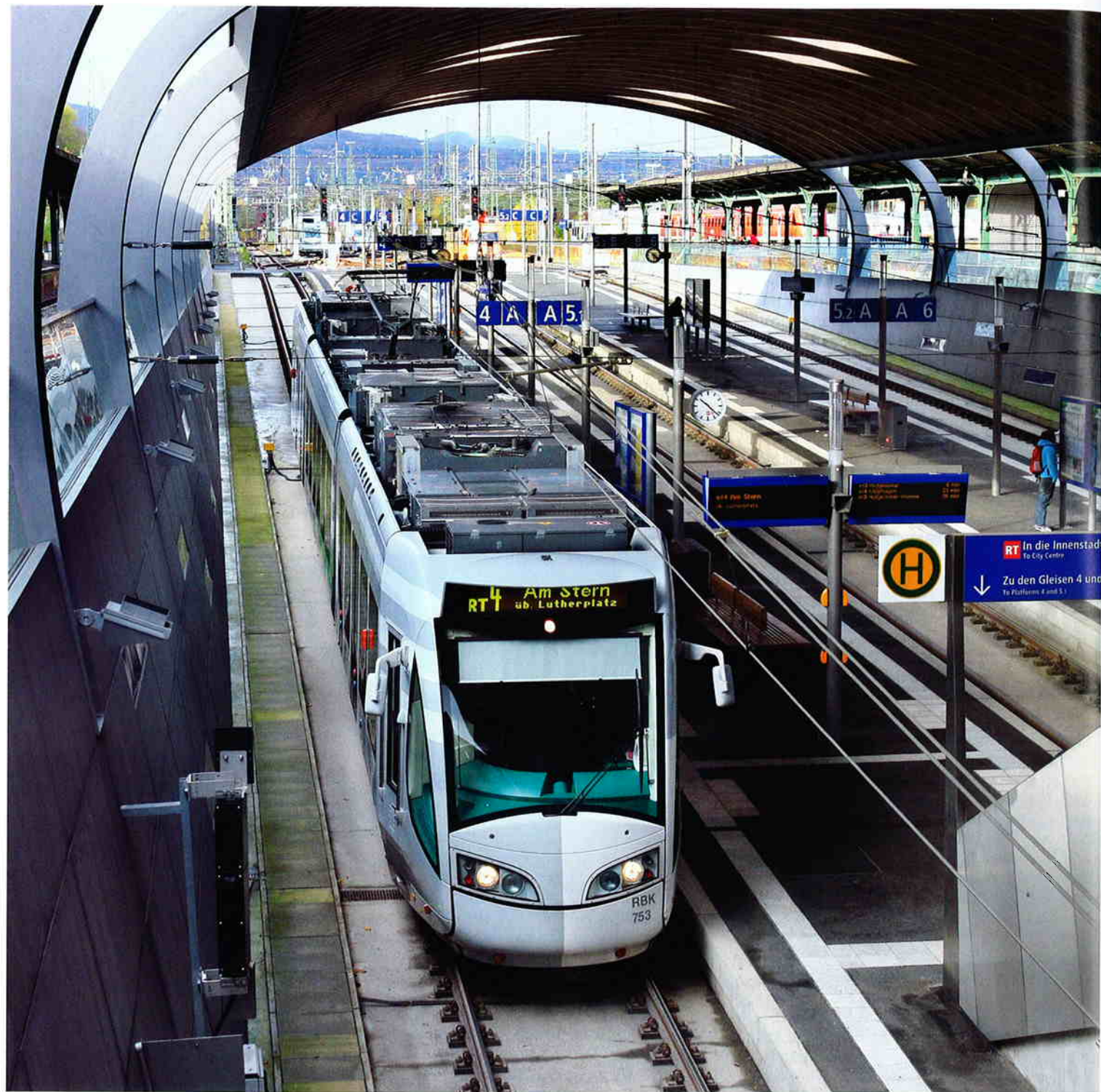
De vroegere kopsporen 4, 5 en 6 in het Kasselse Hauptbahnhof vormen nu de verbinding tussen de sporen van de Deutsche Bahn en die van het stadstramnet in Kassel. Zij liggen in een helling, gaan onder het stationsgebouw en het stationsplein door, komen weer op maaiveldniveau uit en integreren met de stadslijnen. Op het dak is de platte dieselmotor zichtbaar; 4 november 2009.
